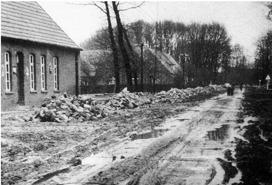
Baustelle Spahn im März 1955. Das Bruchsteinmaterial für die Fundamentierung der neuen Dorfstraße ist bereits geliefert.
