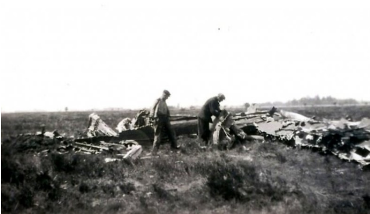
Die Wrackteile eines 1943 abgeschossenen Bombers vom Typ Avro Lancaster bei Twist. Ähnlich muss es am 20.10.1943 an der Absturzstelle eine Lancaster III-Bombers auf „Anneken Land“ wenige hundert Meter süd-östl. von Harrenstätte ausgesehen haben. Hier gab es sechs Tote – einer überlebte. Foto: Sammlung Ikarus
